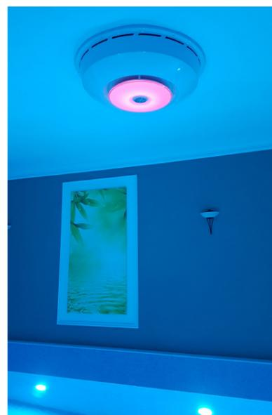
непосредственно у источника испарения. Практически мы смотрим на потолок над спа или бассейном, чтобы оценить размещение. Компрессорная установка должна быть размещена в техническом помещении или где-либо еще на расстоянии 20 м от внутренней единицы.
