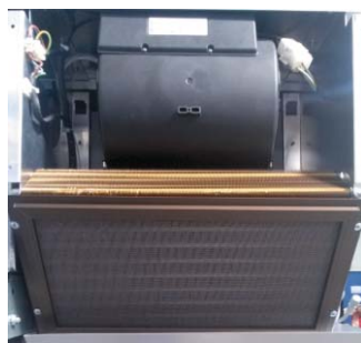
2. Odšroubujte 2 šrouby na pravé straně a lehce uvolněte 2 šrouby na levé straně.
