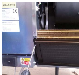
3. Vytáhněte filtr a posuňte ho směrem vlevo dolů.
