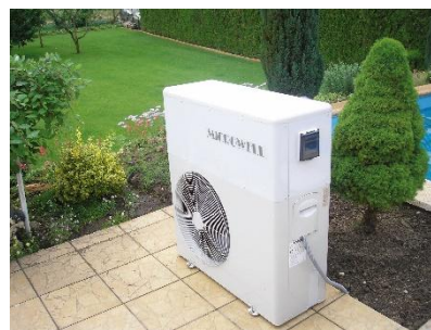
Obrázok: Vzorové pripojenie vody na tepelné čerpadlo. Pružná hadica je nalepená na adaptér matice hadice s vonkajším závitom, ktoré je upevnené na závit výmenníka tepelného čerpadla.
