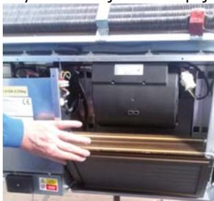
**1.** Odstráňte kryt odvlhčovača. Zvýšenú pozornosť venujte konektoru regulátora, ako sú káble a antény.
