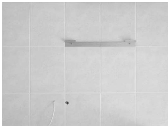
Ukážka prípravy prívodu el. napäcia, odvodu kondenzátu a namontovania konzoly.
