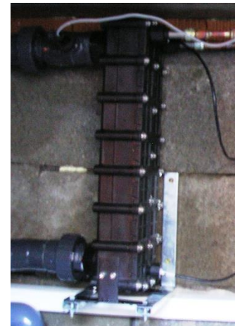
Obrázek: Vodní výměník nainstalovat jedině ve svislé poloze!
