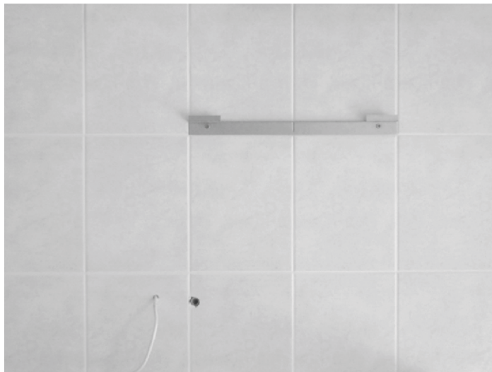
Ukázka přípravy přívodu el. napětí, odvodu kondenzátu a namontování konzoly.
