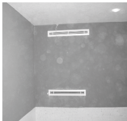
Pohled z bazénové haly
